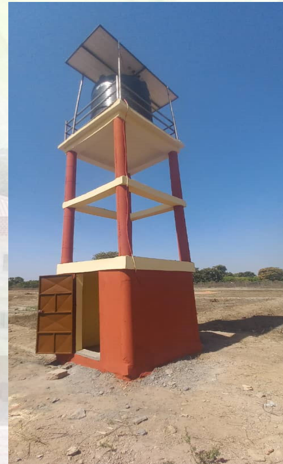
Château d'eau de 5m 3
