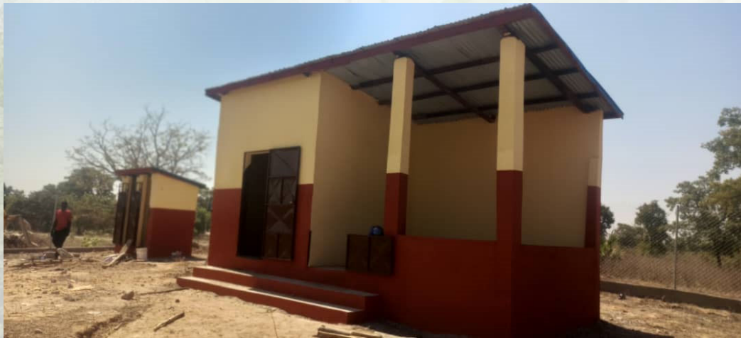
Latrines de type Alafia
