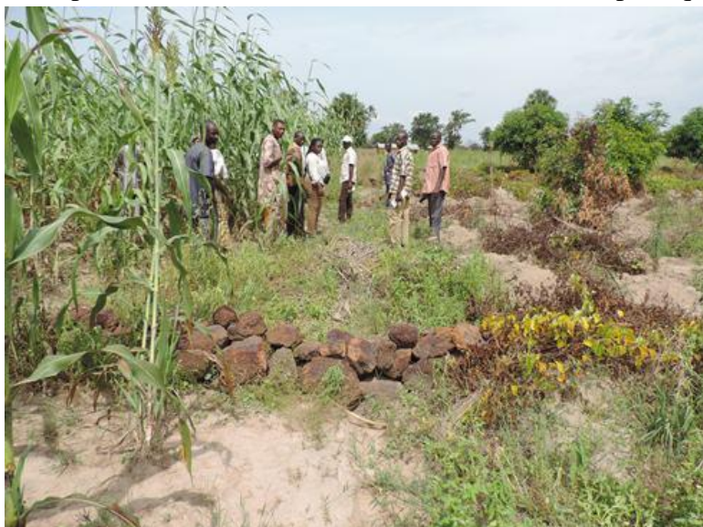
Photo 6 : Dispositifs antiérosifs réalisés dans la commune de Kérou
