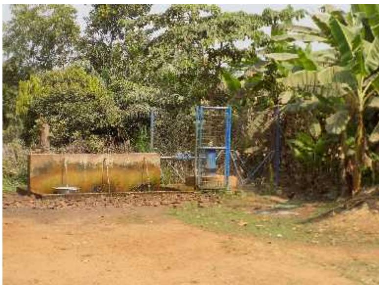
**Photo 9** : Ouvrages de distribution défectueux d'une tête de forage artésien (Agbodji / Bopa)
