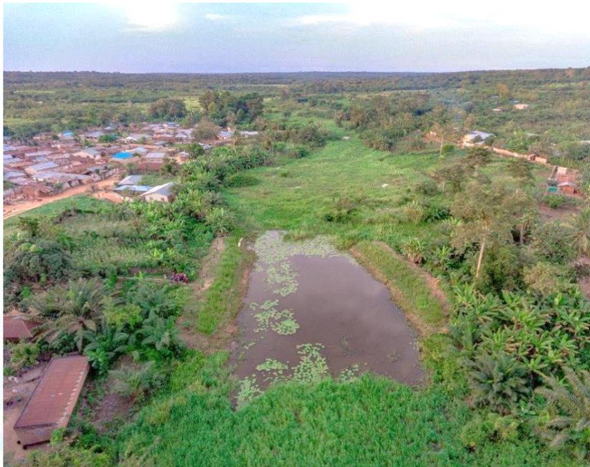
**Amélioration de la capacité de rétention de l'eau des zones humides pour irrigation par un **surcreusement de méandres couplé d'une digue** pour limiter les effets de l'inondation des habitations**
