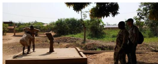
Forage réalisé dans l'école
