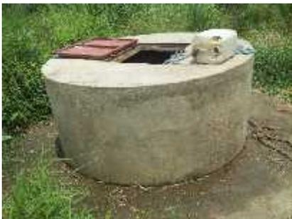
*Photo 1: Puits à grand diamètre sur le site rizicole de Médéhunta*
