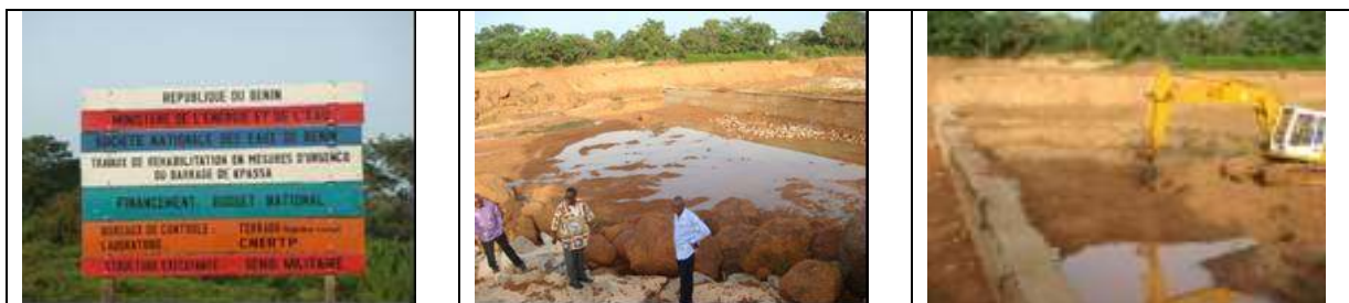
Photo 6, 7 & 8: La retenue d'eau de l'Okpara en cours de réhabilitation sur budget national en octobre 2009
