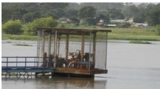
Prise d'eau au niveau Barrage de l'Okpara
