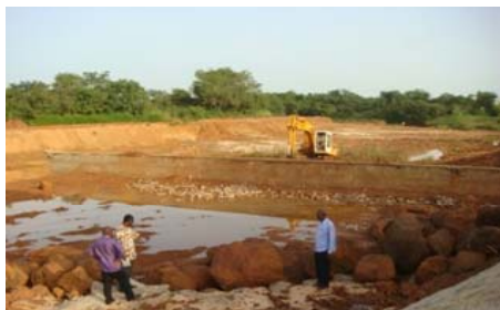
Déversoir du Barrage de l'Okpara en réhabilitation
