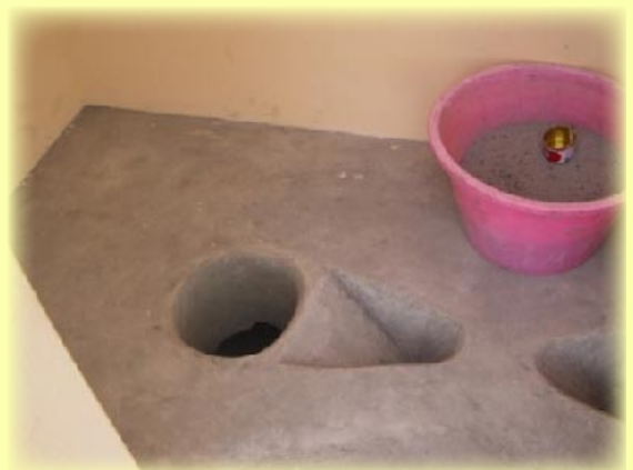
Cuvette de latrines ECOSAN
