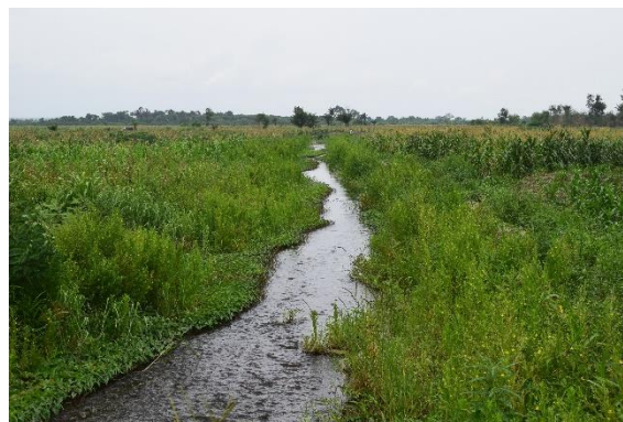
Désencombrement de voies d'eau dans la commune de Zè par le projet PSL Eau
