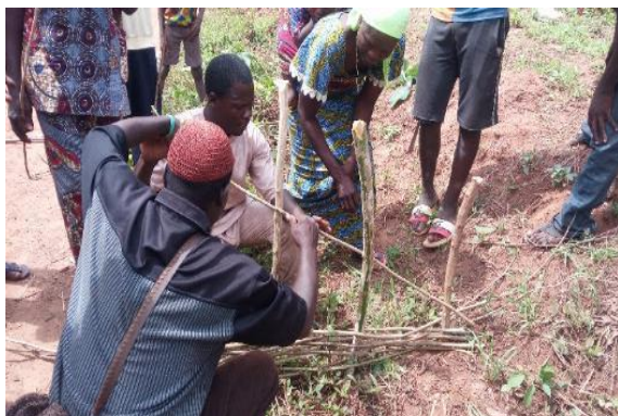
Formation du projet GIRE-PSE à Zogbodomey pour la réalisation de techniques CES (ici une fascine) pour lutter contre l'érosion
