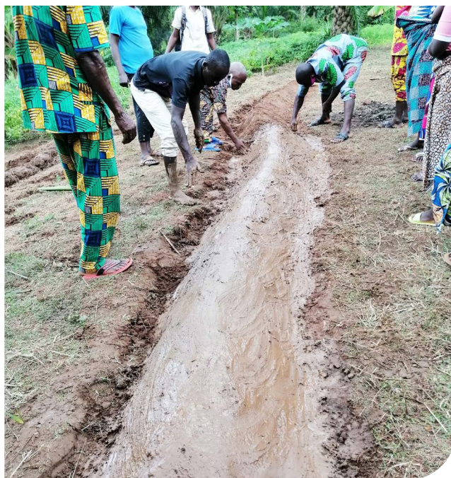
Formation sur la réalisation des diguettes en terre consolidées afin de limiter l'érosion du sol à Kotokpa, commune de Zogbodomey, septembre 2020 (CIDR Pamiga)
