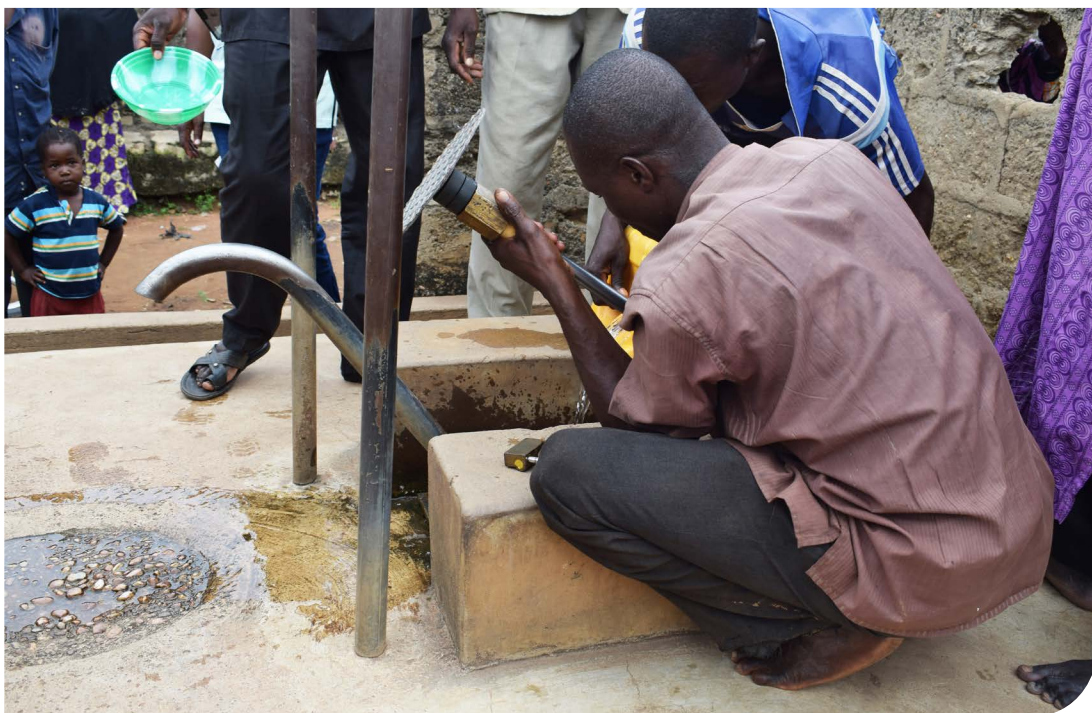
Artisan-réparateur dépannant un forage équipé de pompe à motricité humaine à Koda N'Kparou, commune de Gogounou, octobre 2019 (SNV Bénin)
