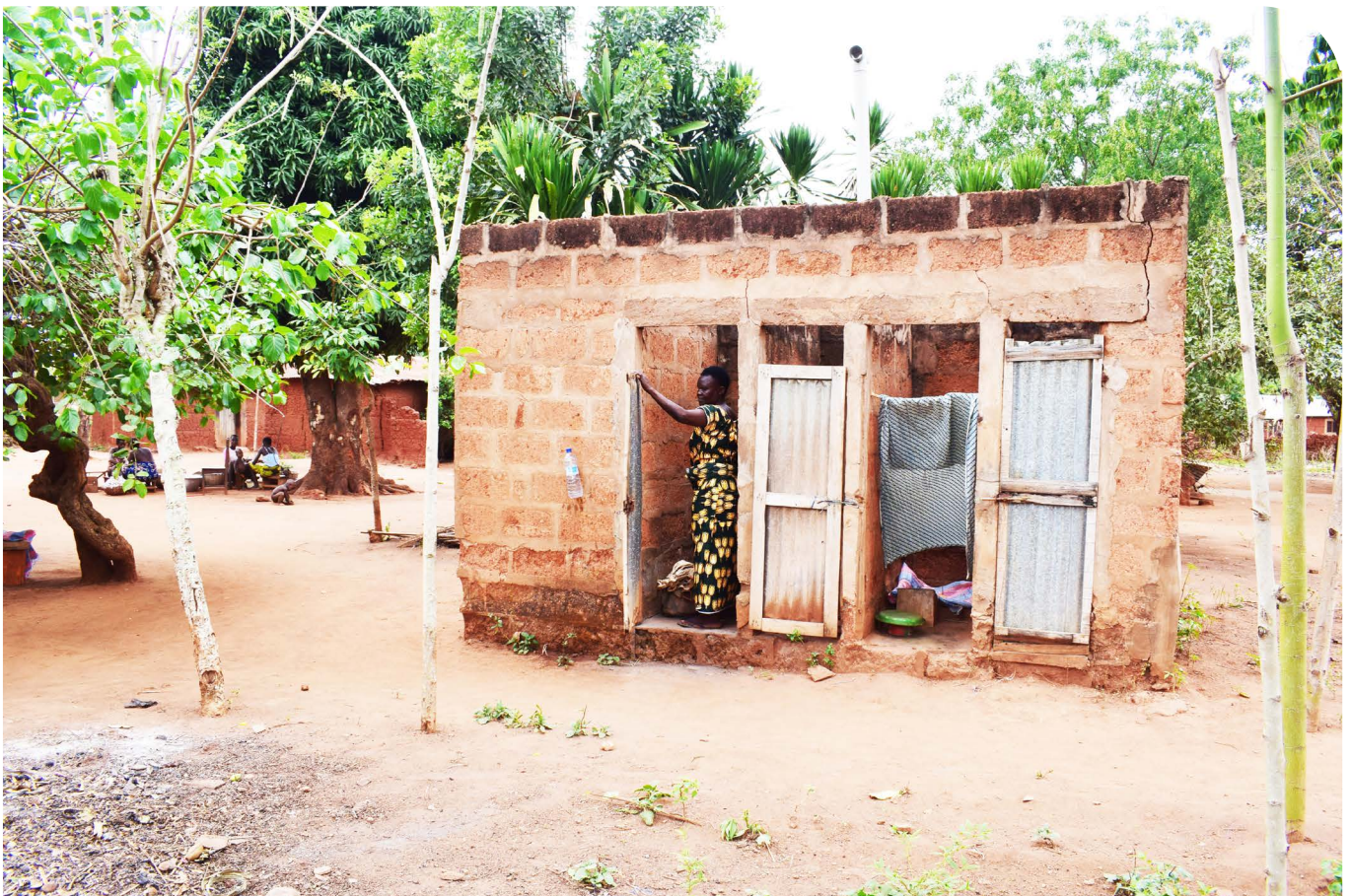
Tous les ménages ont réalisé et utilisent chacun une latrine familiale dans le village de Makpéhogon, commune d'Agbangnizoun. Un groupement de femmes se charge du suivi post-FDAL et s'assure de l'utilisation et de l'entretien adéquat des latrines (propreté, couverture du pot de WC, etc.), avril 2022 (SNV Bénin).
