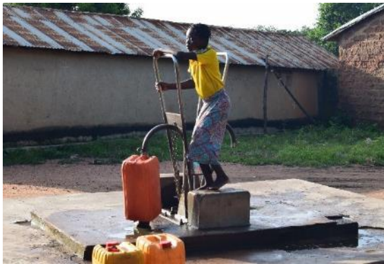
Forage équipé de Pompe à Motricité humaine (FPM) réhabilité à Ouèrè Bani avec l'appui du projet AEPHA exécuté par ANAP (Commune de Gogounou).
