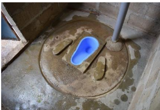
Latrine hygiénique modèle « Watè Alafia » réalisé par un micro-entrepreneur promu par Helvetas à Gamia (Commune de Bembéréké).
