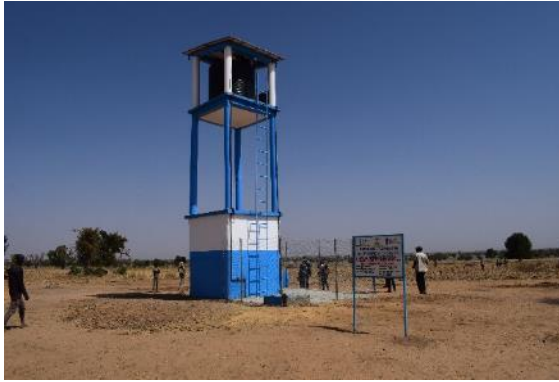
Poste d'Eau Autonome (PEA) solaire réalisé et mis en service à Bako Maka avec l'appui du projet riposte Covid exécuté par SIA N'SON (Commune de Karimama).
