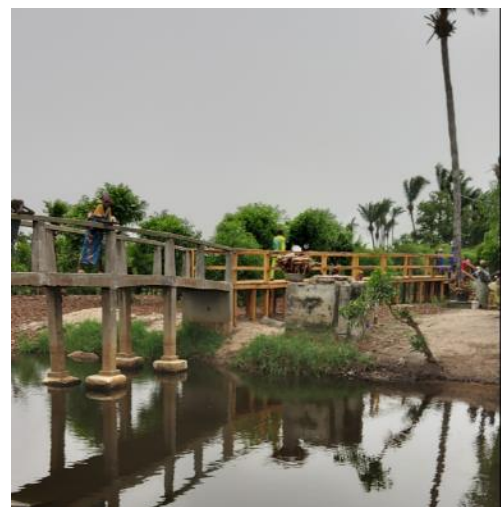
Prolongement en bois de la passerelle du village de Kpaffè (Commune de Sô-Ava) par le projet PSL Eau .
