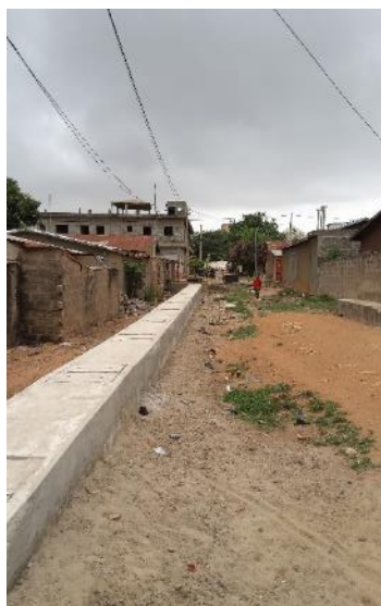
Réalisation de caniveaux d'évacuation par le projet PSL Eau à Tokpa-Zoungo (Commune d'Abomey-Calavi).
