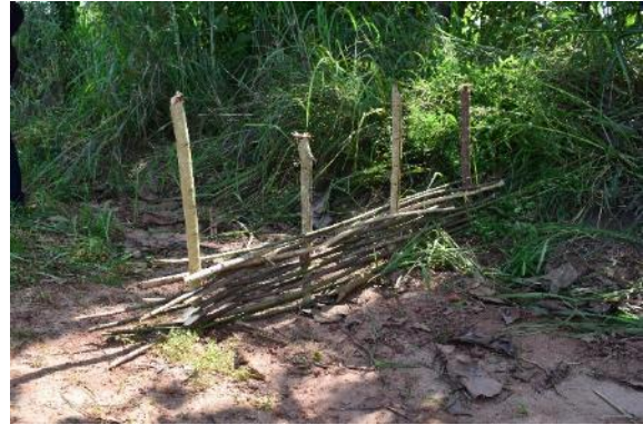
Réalisation d'une fascine, une des techniques CES du projet GIRE-PSE pour lutter contre l'érosion à Zogbodomey.
