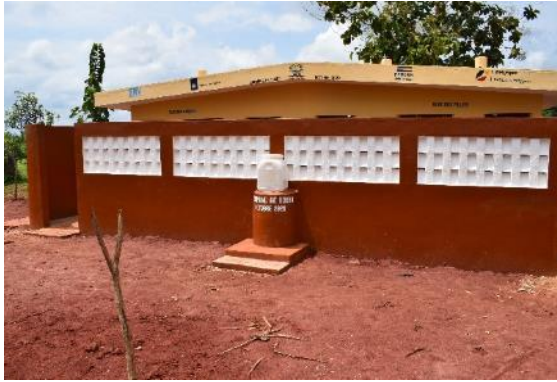
Bloc sanitaire HSS réalisé à l'EPP Lokogba III par le projet InnEAUvASSion exécuté par Protos-Join for Water (Commune de Dogbo).
