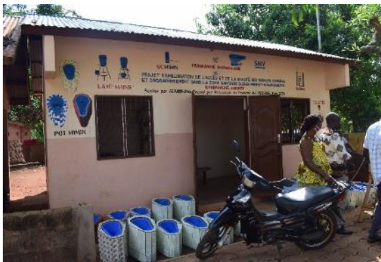
Sanimarché d'Abomey réalisé et mis en service avec l'appui du projet AEPHA exécuté par AERAMR (Commune d'Abomey).
