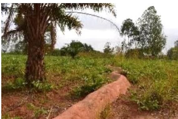
Réalisation de diguettes en terre et ciment, une des techniques de conservations des eaux et des sols (CES) introduite par le projet GIRE-PSE pour lutter contre l'érosion à Houégo Aga (Commune de Zogbodomey).
