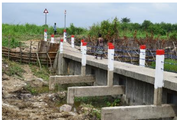
Passerelle munie de dispositifs de régulation du flux hydrique réalisée par le projet PSL Eau à Ahomey Lokpo (Commune de Sô-Ava).
