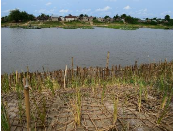
Reboisement et protection de la berge par le projet NVW (vétivers et toiles de jute en jacinthe d'eau) à Adjohoun afin de lutter contre l'érosion
