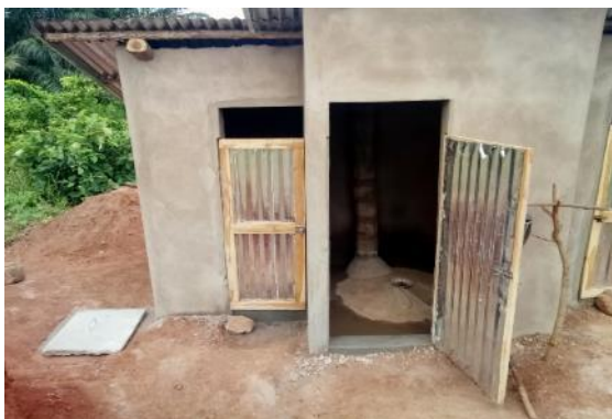
Latrine à dérivation d'urines réalisée par un ménage avec l'appui-conseil de AERAMR à Assantoun (Commune de Djidja).
