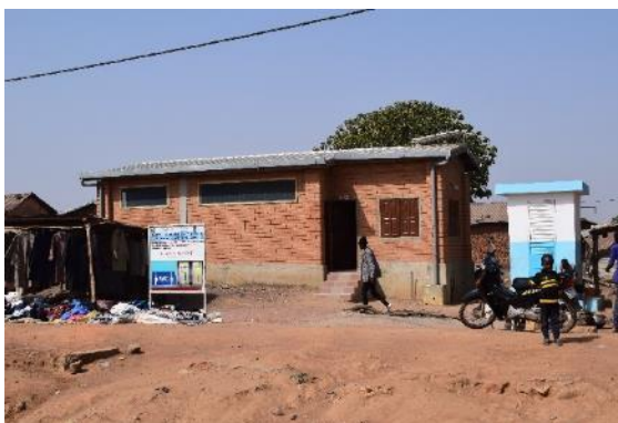
Bloc sanitaire public avec Kiosque à eau réalisé en BTC à Sori avec l'appui du projet AEPHA exécuté par Helvetas (Commune de Gogounou).
