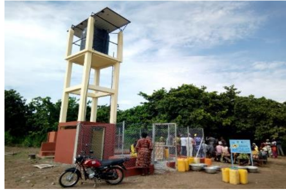
Poste d'Eau Autonome (PEA) solaire réalisé et mis en service à Sinasso dans le 3 ème Arrondissement avec l'appui du projet AEPHA exécuté par AProDESE (Commune de Parakou)
