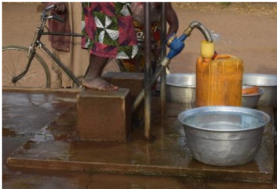
FPM muni de compteur d'eau à Allérou Gah avec l'appui du projet AEPHA exécuté par AProDESE (Commune de Parakou).
