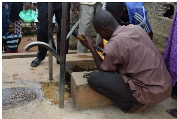
Forage équipé de Pompe à Motricité humaine (FPM) hors service depuis 2016 réhabilité à Koda N'Kparou avec l'appui du projet AEPHA exécuté par ANAP (Commune de Gogounou).
