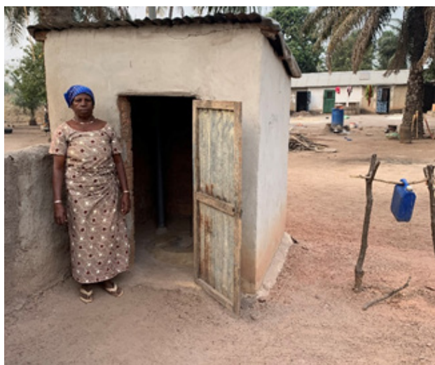
Habitante de Onklou 2 dans la commune de Djougou ayant réalisée sa latrine
