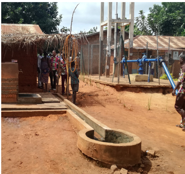
Borne fontaine sur le site aménagé d'un forage artésien à Dogbo
